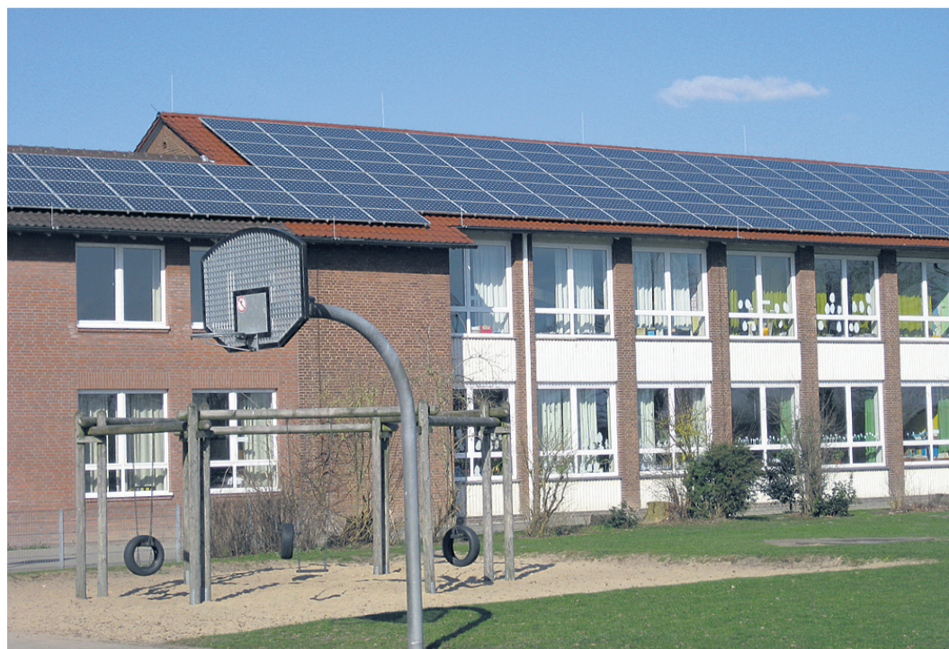
Die erste Bürger-Photovoltaikanlage wurde auf das Dach der Lambertus Grundschule gesetzt.
